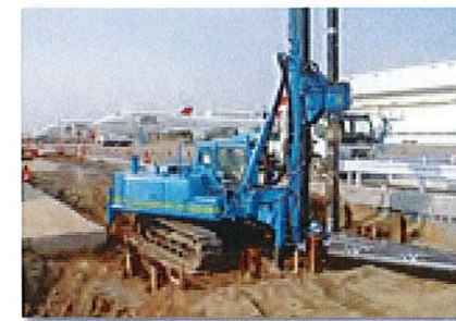
工場内での施工
