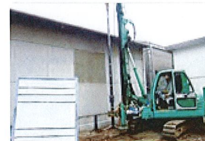
施工は無排土
