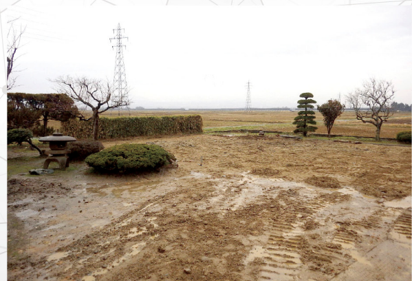
杭打設後もきれいな現場
