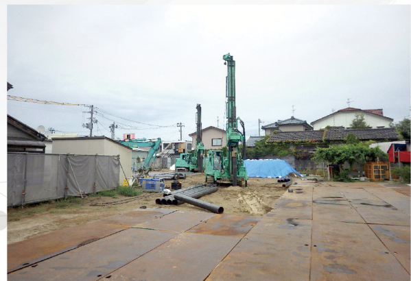
杭打ち専用機2台で大型工事施工
