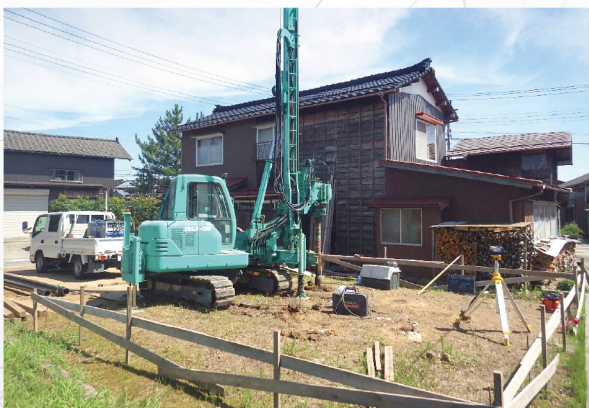
狭い現場もらくらく施工
